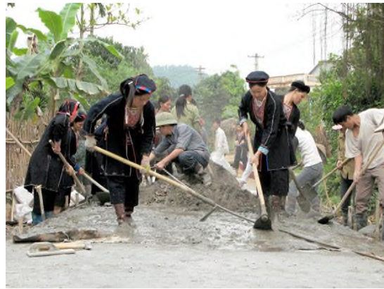
Nhân dân thôn Khe Đàng, xã Tứ Quận (Yên Sơn) làm đường bê tông nông thôn.. Ảnh: Thùy Linh
